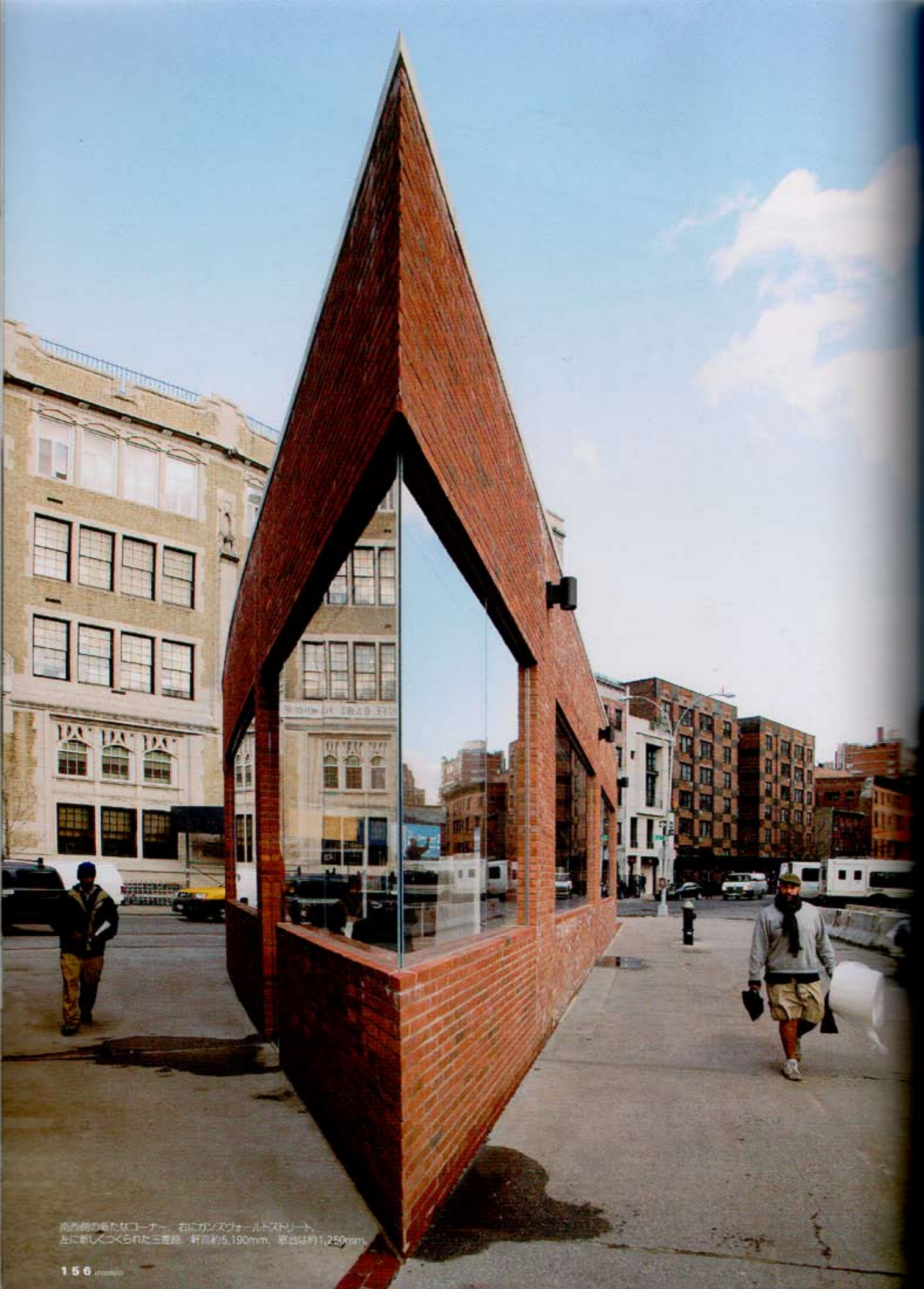
東側コーナーは曲面状に煉瓦壁を積み直し、連続する曲面の壁としている。地面に残る煉瓦積跡の三角部分が既存建物のかたち。三差路の印象を変えている。
